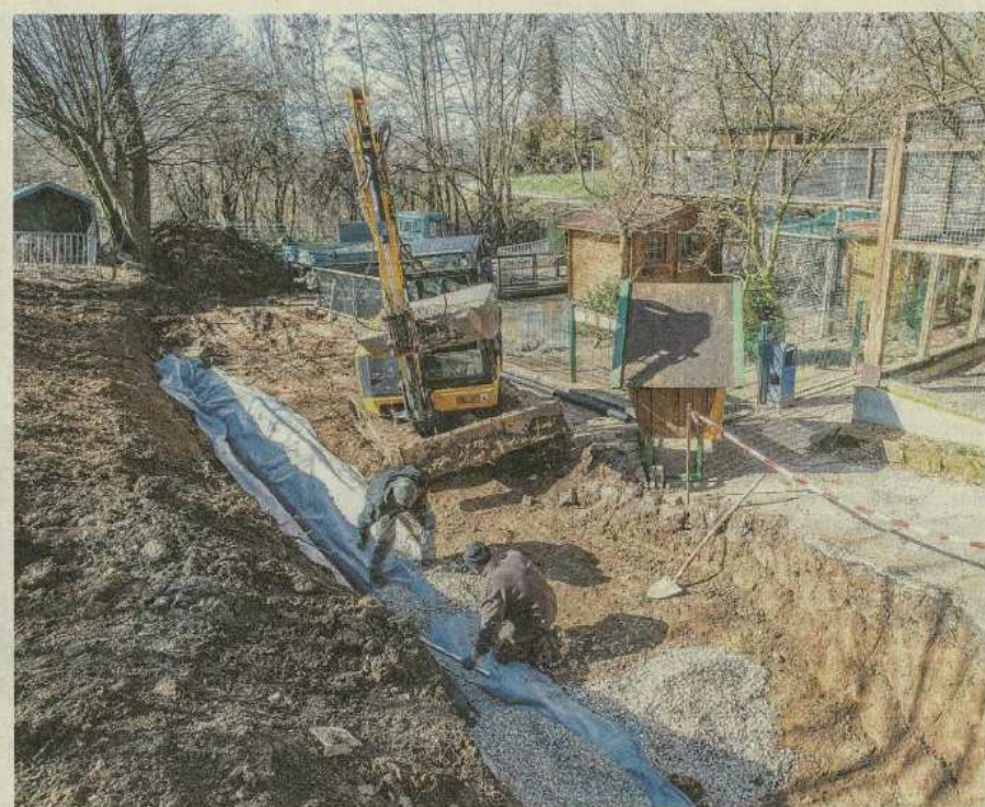
Bagger und Bauarbeiter sind derzeit im Göppinger Tierpark zugange. Die Anlage wird nach langen Streitereien jetzt grundlegend umgestaltet. Foto: Staufenpress
